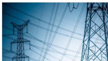
Distribuzione di energia elettrica
